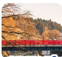
สะพานนากะบาชิ
